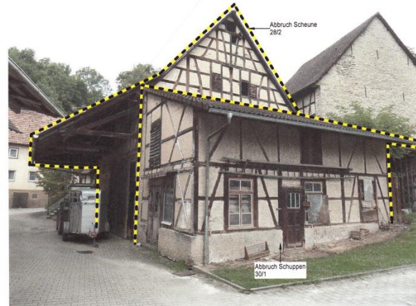
Ansicht von Süd
